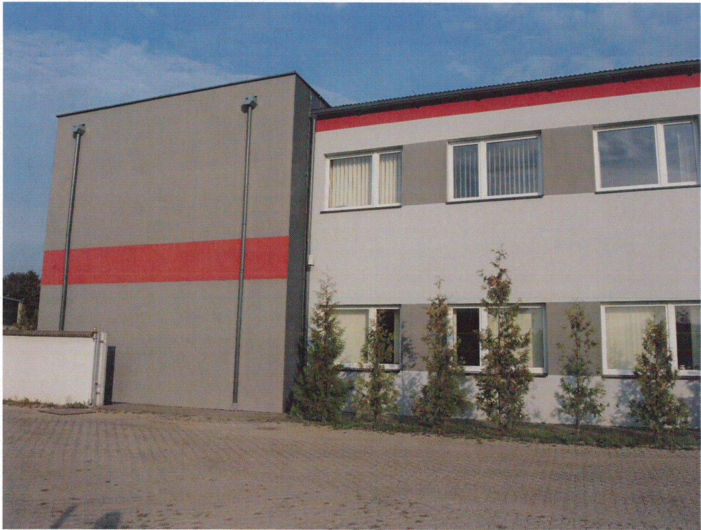
Budynek biurowo - magazynowy.
