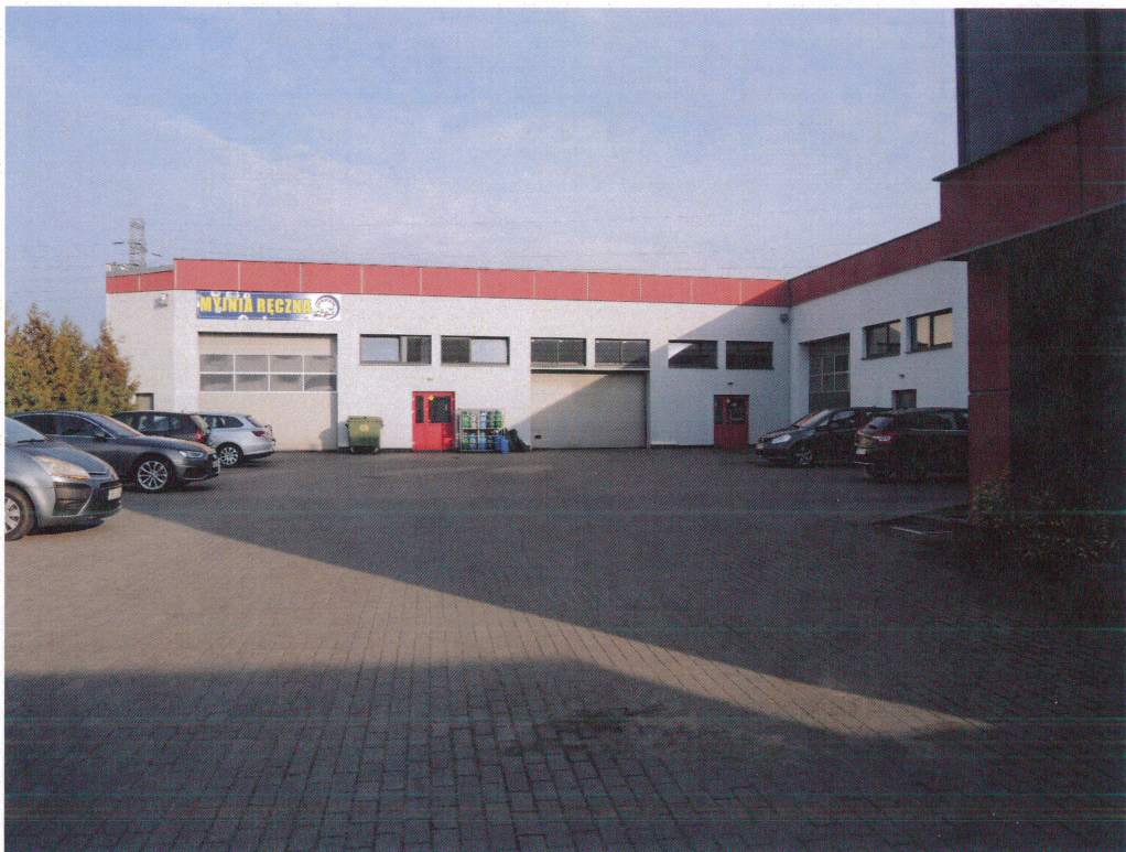
Budynek biurowo - magazynowy.
