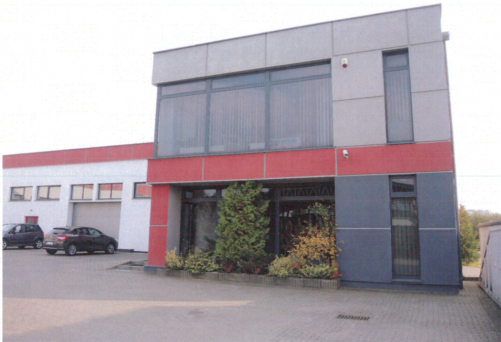
Budynek biurowo - magazynowy.
