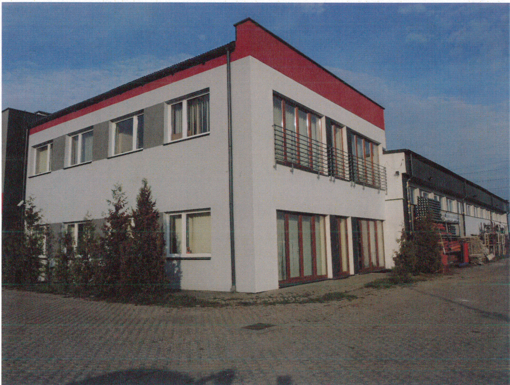
Budynek biurowo - magazynowy.
