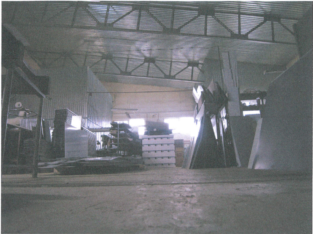
Widok wnętrza budynku.
