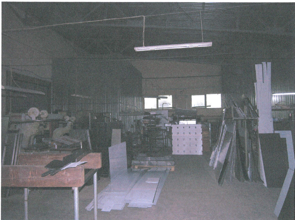
Widok wnętrza budynku.
